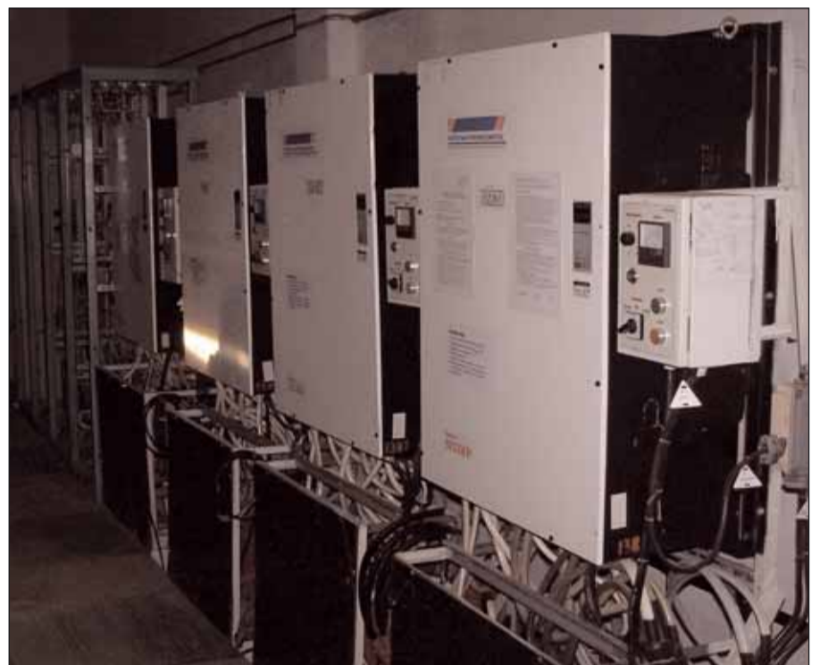
К двигателям насосов, обслуживающим железнодорожный терминал и перекачку нефти на танкеры, подключено 15 преобразователей частоты фирмы «Веспер» разной мощности
