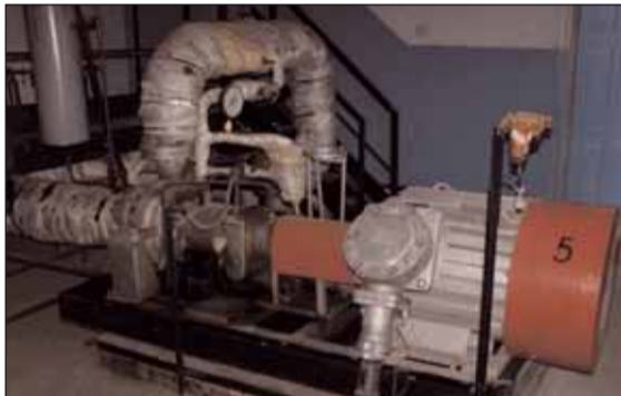
К двигателям насосов, обслуживающим железнодорожный терминал и перекачку нефти на танкеры, подключено 15 преобразователей частоты фирмы «Веспер» разной мощности
